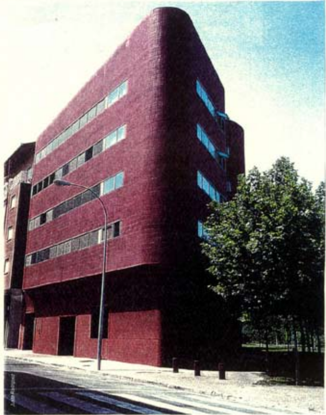
Tres imágenes de las viviendas bioclimáticas que ha construido el IRVI en la calle Rodancha de Logroño
