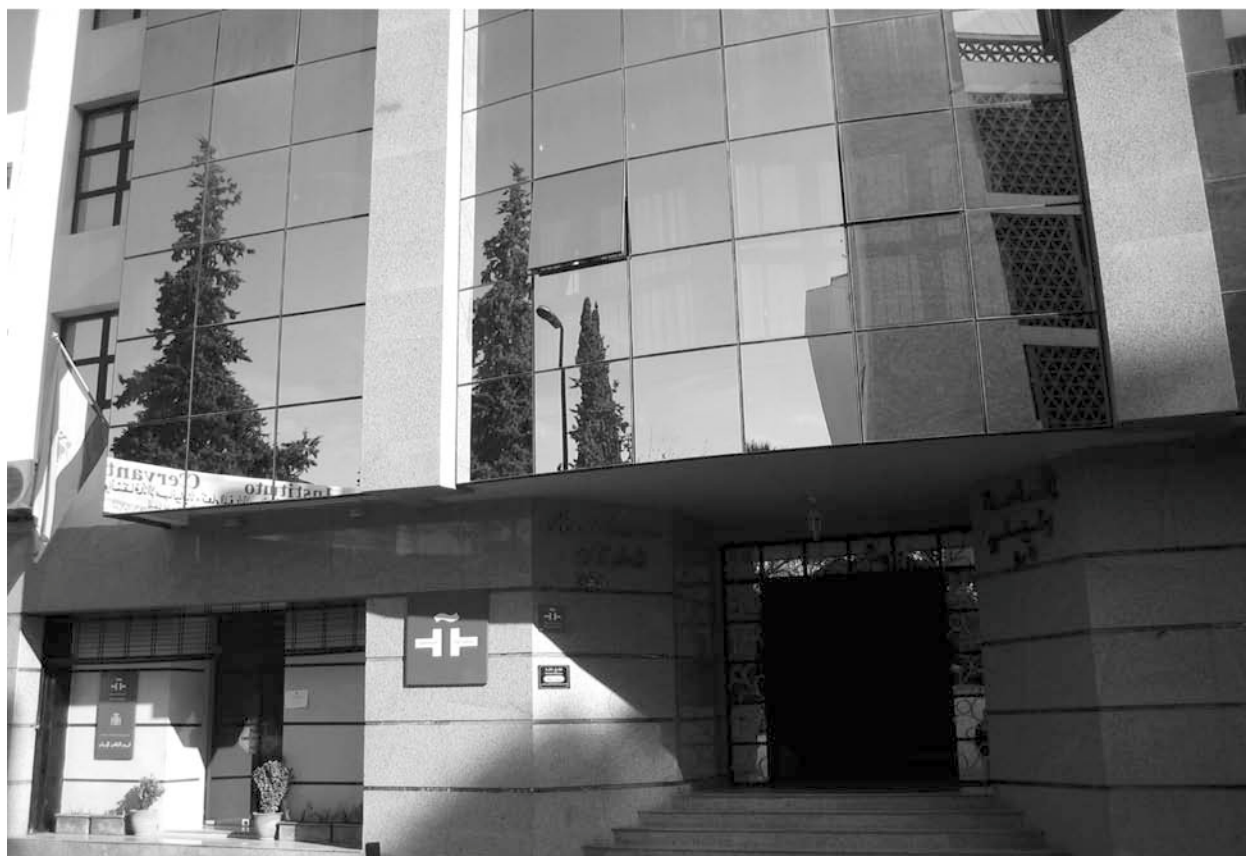
Fachada principal del I.C. de Fez
