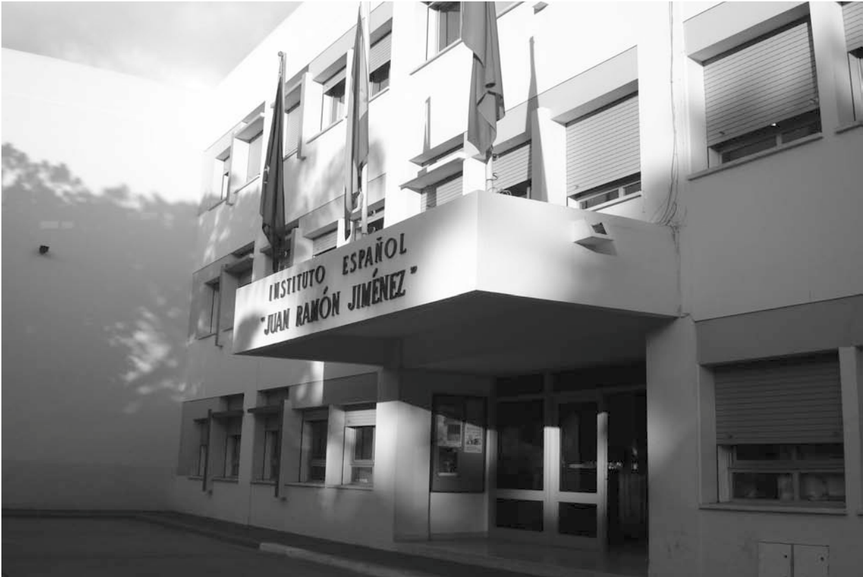
Fachada interior del Centro
