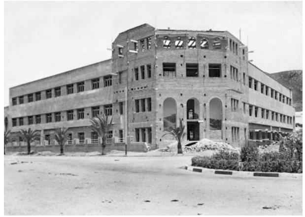
El Pilar en construcción (1935).
