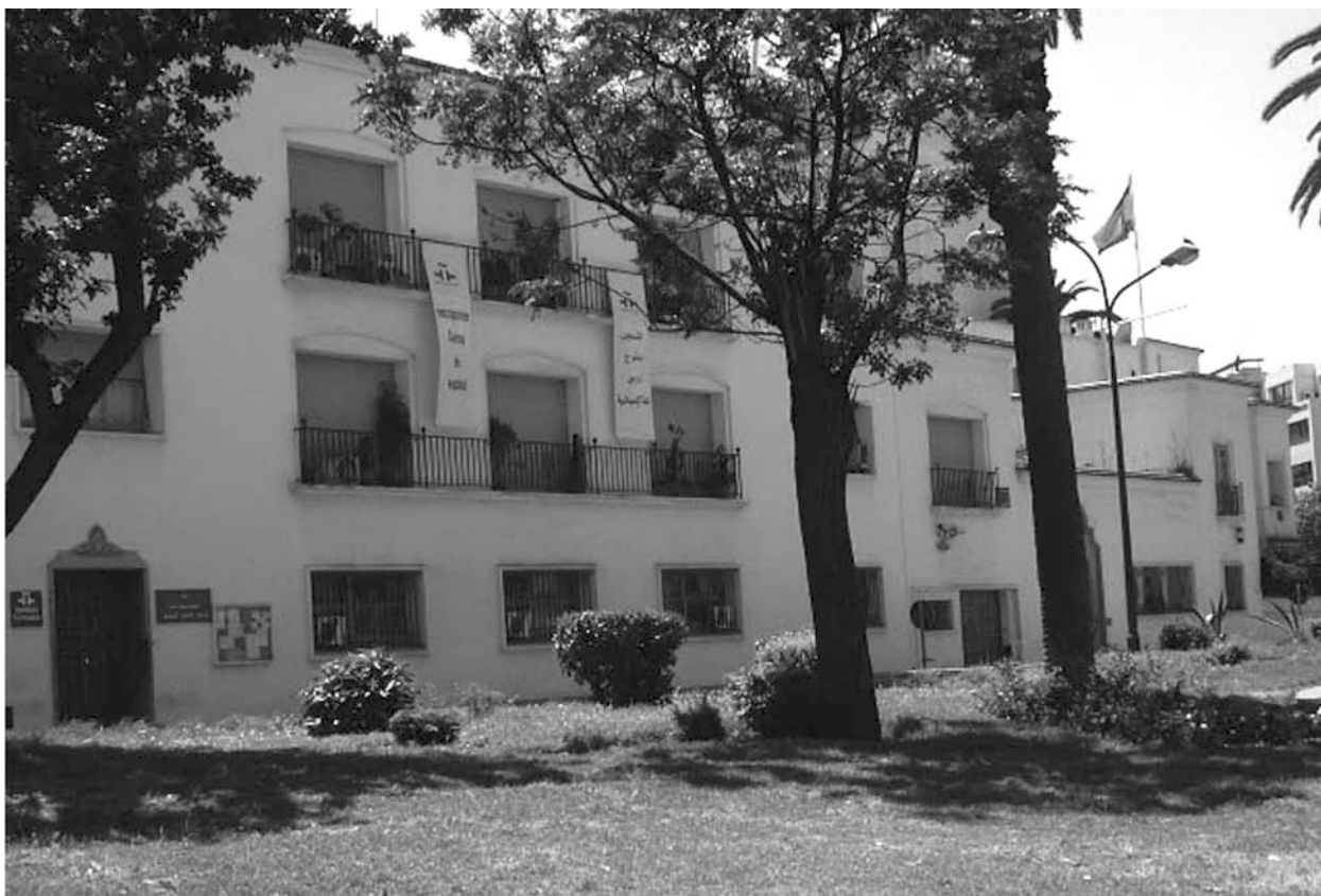
Fachada principal del I.C. de Rabat
