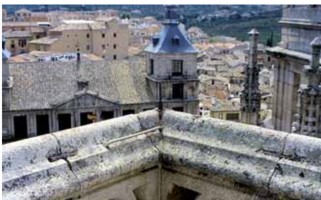
Figura 1. Grapas vistas de hierro y de acero inoxidable para la unión de sillares de parapetos de granito (Catedral de Toledo). Fotografía: Rafael Fort.
