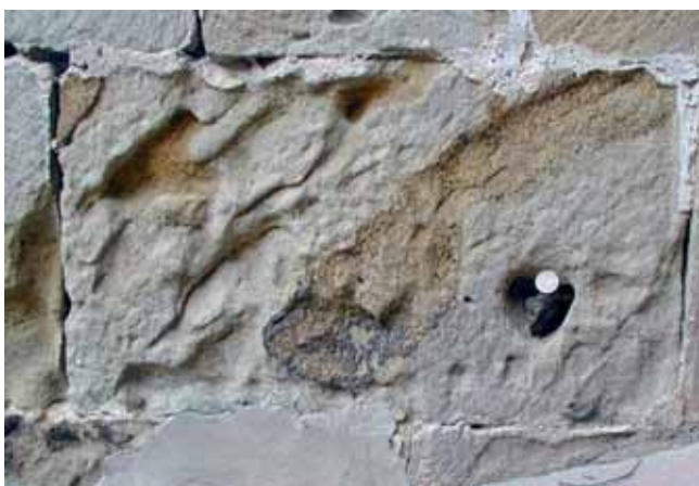
Figura 10. Nódulos metálicos naturales en arenisca que provoca falsa detección de grapas. Fotografía: Rafael Fort.
