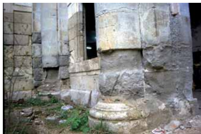
Figura 1. Pérdida de cohesión en rocas carbonáticas del claustro de la Catedral de Cuenca.
