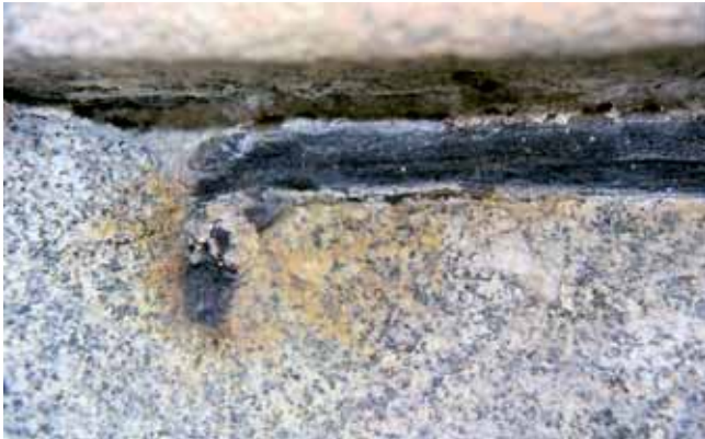
Figura 7. Migración de óxidos de hierro procedente de una grapa de hierro ensamblado en granito. Fotografía: Rafael Fort
