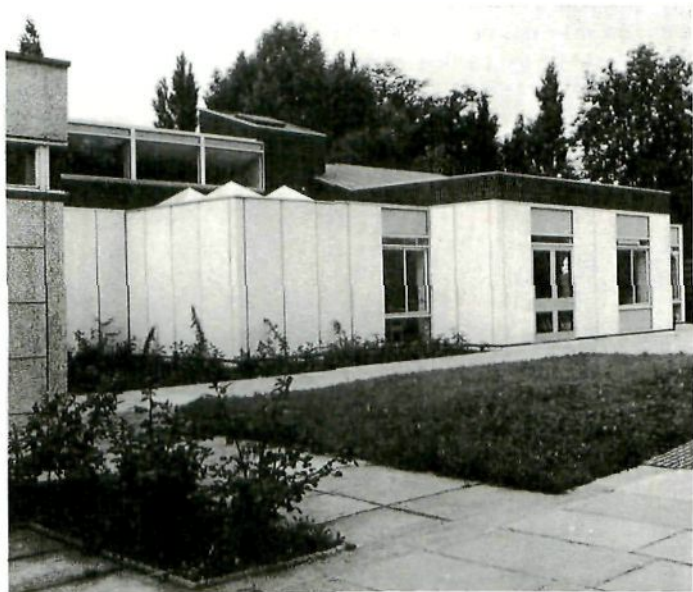
Figura 18.—Los dispositivos para iluminación desde el techo son componentes importantes de un sistema cuando en un plano en profundidad es necesaria la iluminación natural. Se ofrecen aquí dos tipos de dispositivos: uno de tipo piramidal, que proporciona una luz vertical; el otro que proporciona una iluminación de calidad diferente a partir de claraboyas en un tejado en chaffán
