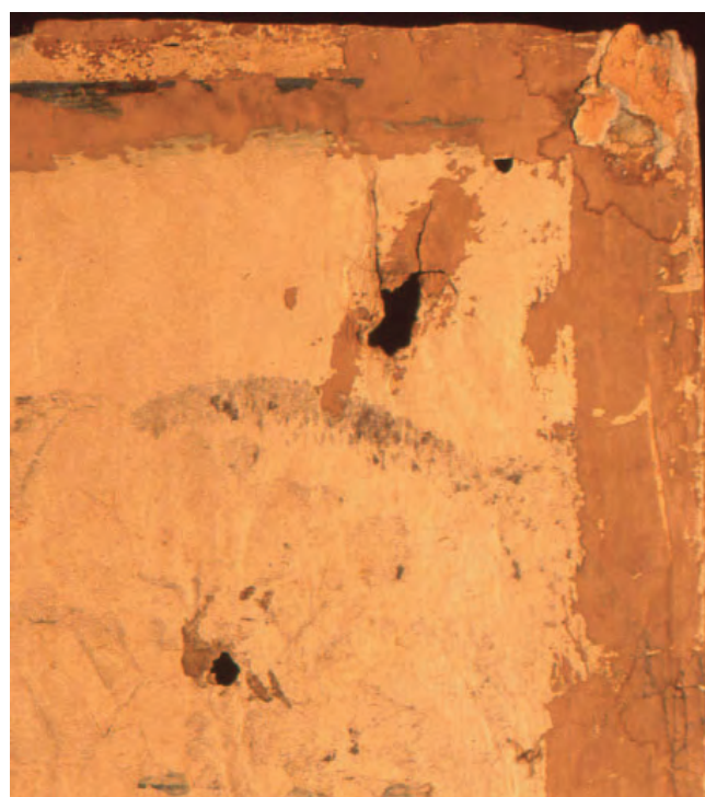
Fig. 38 Estado de conservación: detalles de daños.
