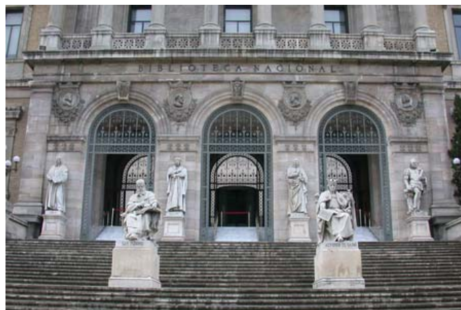
Imagen: Fachada de la Biblioteca Nacional (Madrid) Fuente: Banco de imágenes del INTEF
