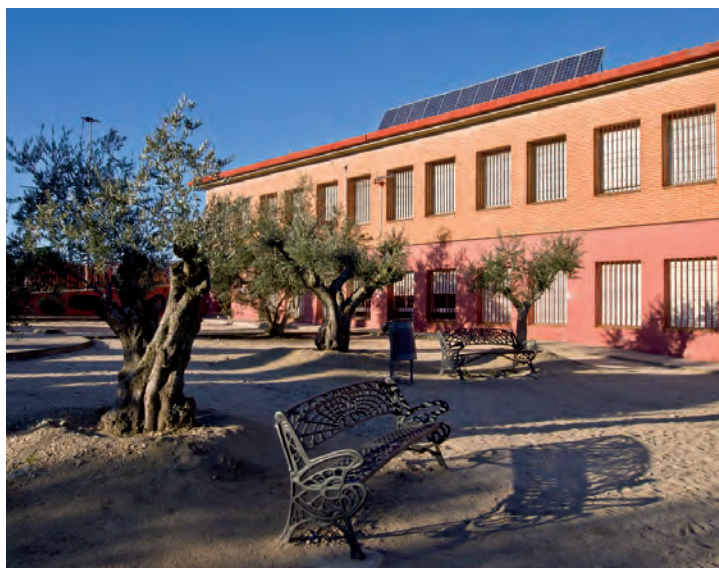
Paneles solares fotovoltaicos en el tejado de nuestro IES.
