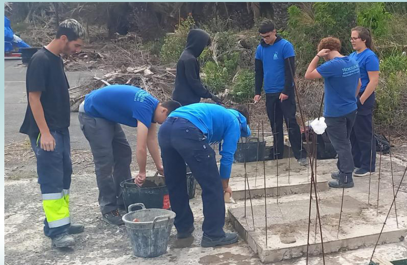
Alumnado construyendo balsas de depuración natural para reducir la huella de carbono en una estación de depuración de aguas residuales
