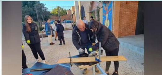
Familias, alumnado y personal del centro trabajando en la bio-autoconstrucción del Aula Verde
