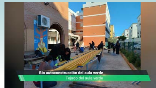
Fotograma del vídeo sobre la bio-autoconstrucción del Aula Verde
