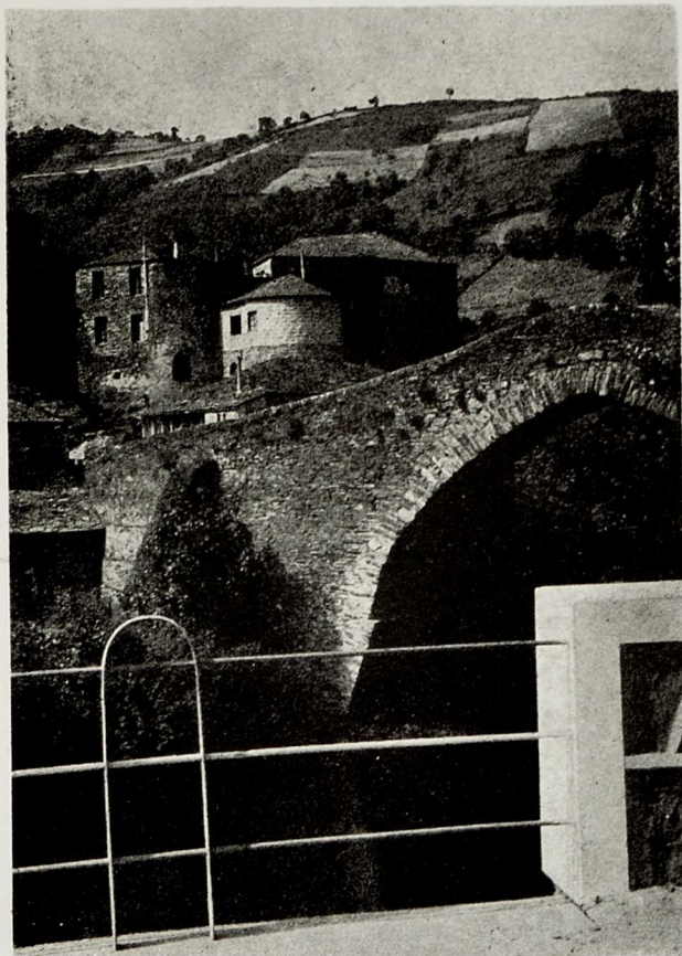
El río Navia, navilivium de los romanos, famoso por sus truchas, tiene en la Puebla dos puentes: el de estilo románico y el de moderna construcción. Al fondo, el vetusto castillo.
