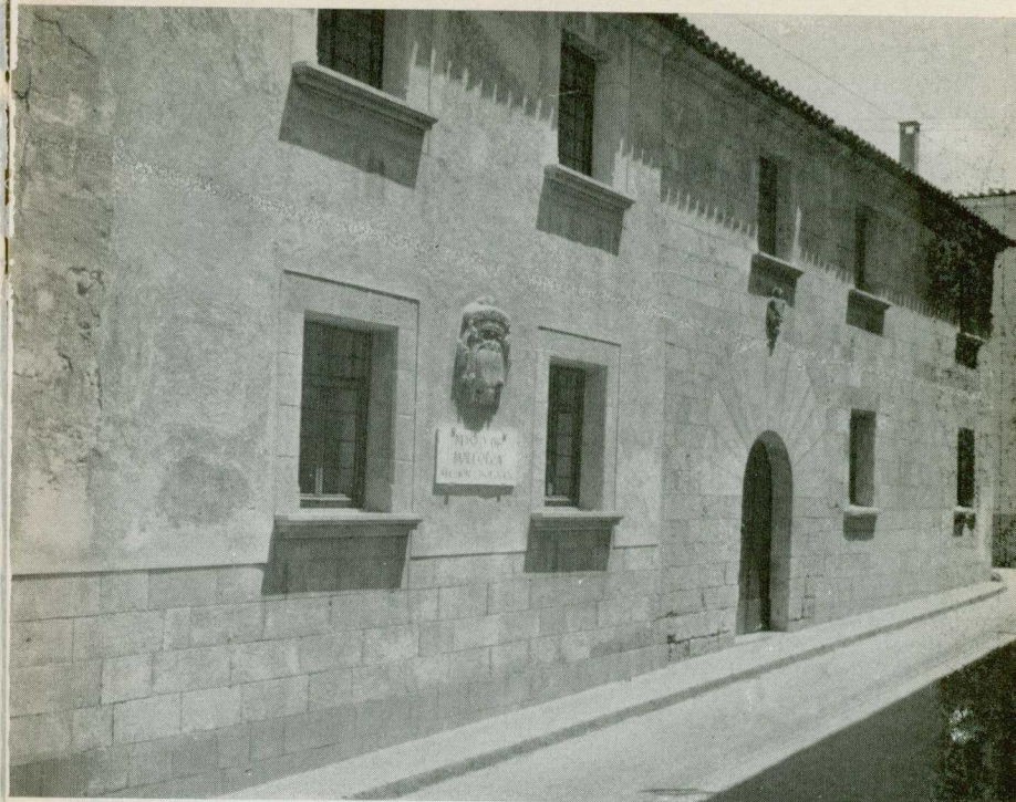
Fachada del Museo a la calle Mayor
